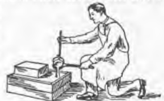
Fig. 4—Pouring the Metal
